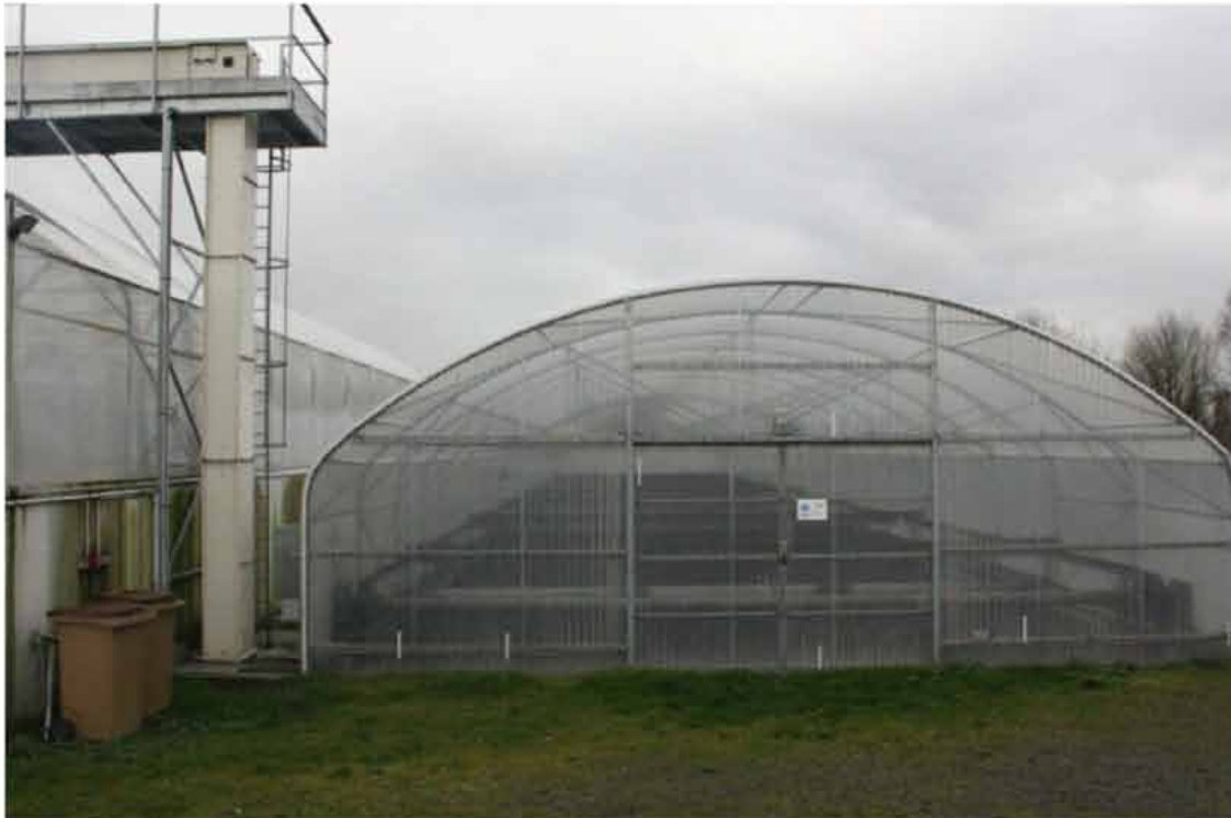
La réalisation des travaux à la station d'épuration de Machecoul avait été confiée en 2008 à un groupement d'entreprises. ©archives
