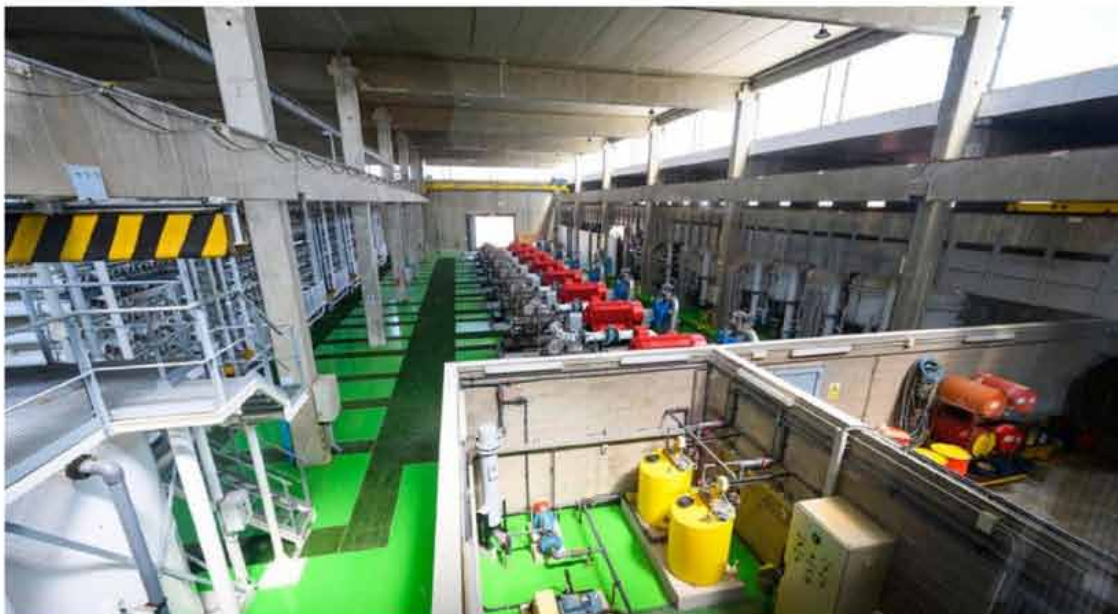
Desaladora de Almería.
