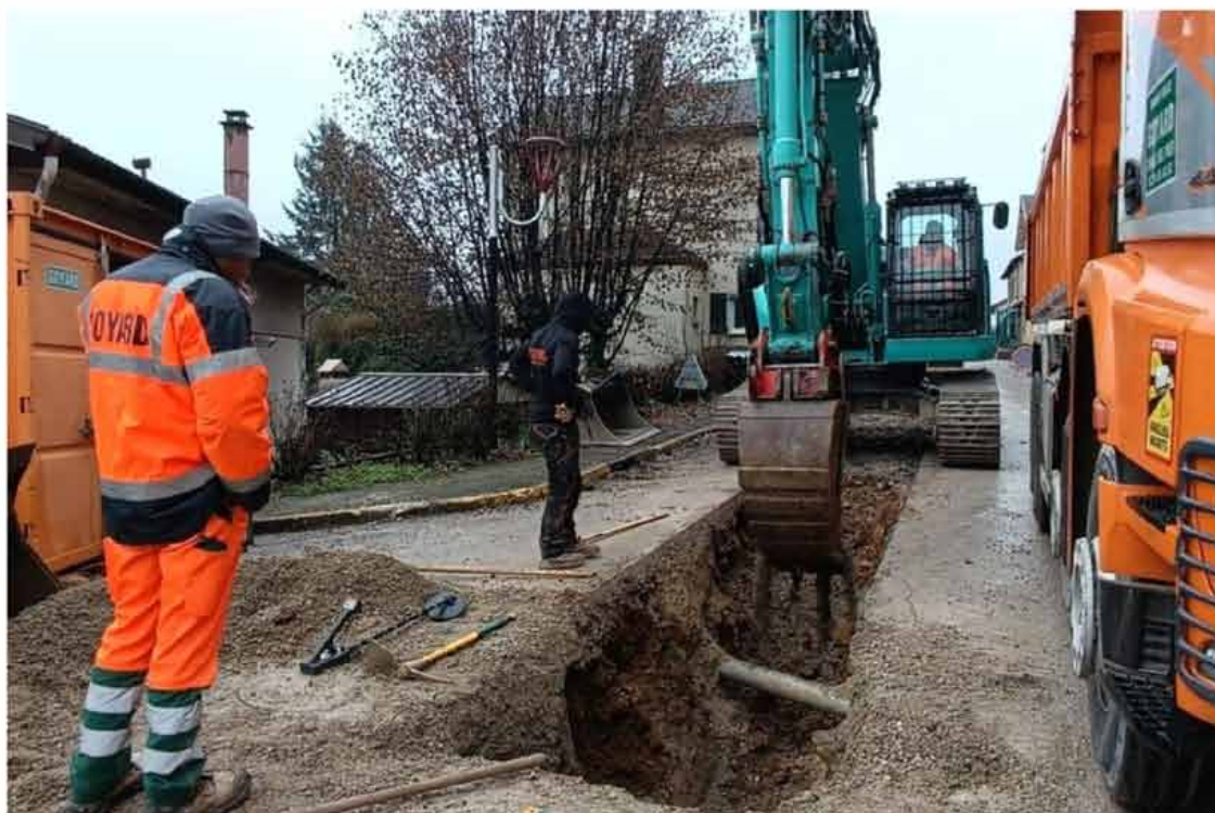
Les chantiers concernant les réseaux deau potable et dassainissement vont se succéder. (Illustration) ©Valentin Machard
