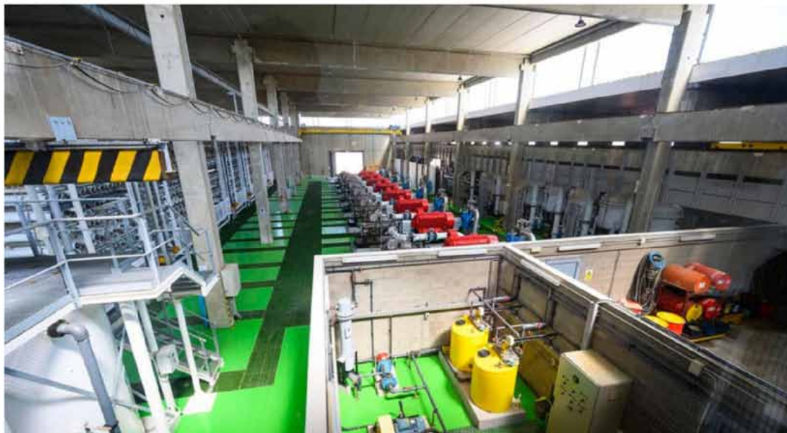
Desaladora de Almería.
